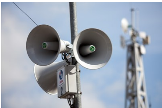
Instalace nového obecního rozhlasu
